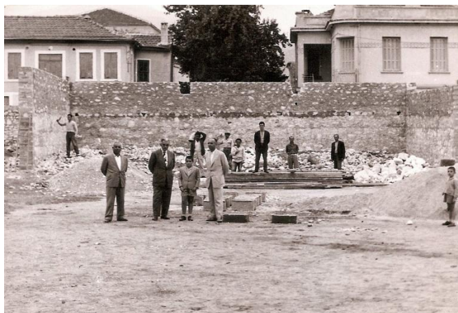
Ανέγερση υπόστεγου γυμναστικής, 1958. Πηγή: Φωτογ. αρχείο Αβραάμ Γεωργιάδη
