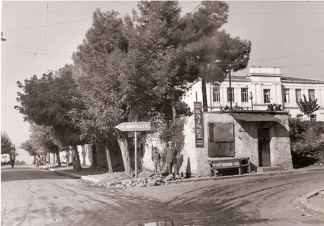
Στη φωτογραφία (1957) φαίνεται το νοτιοανατολικό άκρο της αυλής των Εκπαιδευτηρίων, όπου υπήρχε κτίσμα, καθώς και ο γκρεμισμένος τοίχος της. Στη θέση του τοποθετήθηκε το άγαλμα του Χρυσόστομου. Πηγή: Φωτογρ. αρχείο Αβ. Γεωργιάδη.
